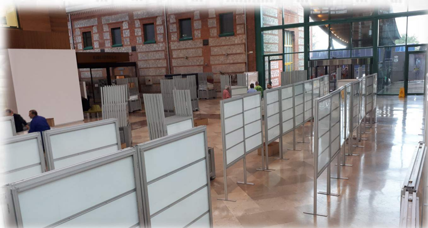
DESCARGA Y MONTAJE DE VITRINAS
