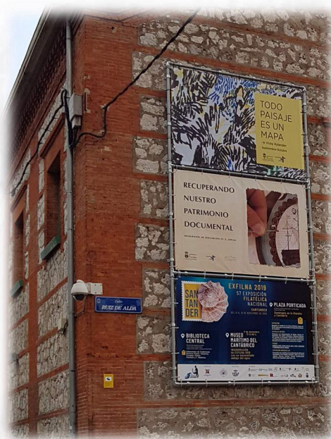
FACHADA DE LA BIBLIOTECA
